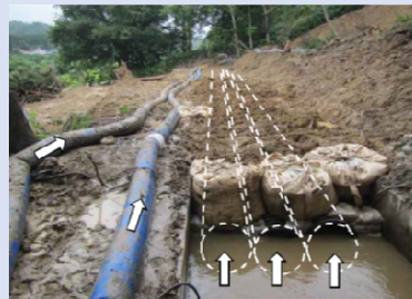
伐採作業・仮設管設置
